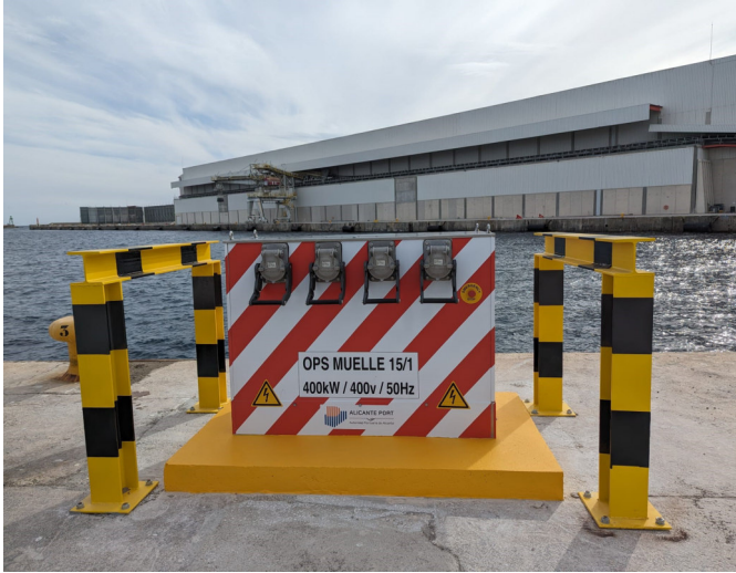
Instalación OPS en los muelles 13, 15 y 17 del Puerto de Alicante.
