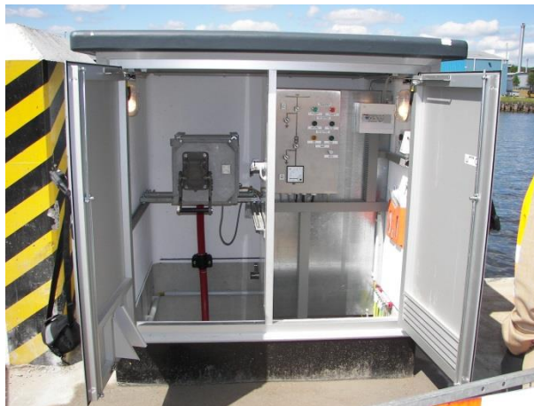
Prise type 3PX5 7kV 200A 3P+T+2p Suède / Sweden
