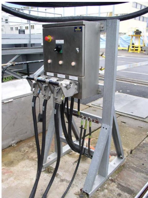
Prises unipolaires type 3PXU 650A 440V France 3PXU single pole 650A 440V
